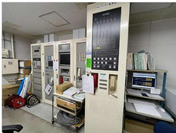
①空調管理、②電力監視、③冷温水設備監視、④防災監視、⑤エレベータ、エスカレータ監視ですが、ホテルの人件費削減の為に本来ホテル側で行うべき、①客室内の補修対応、②レストラン厨房設備の修理対応、③館内の照明器具の故障対応や電球交換対応、④トイレ等水回りの修理も請け負っているため、さながら何でも屋になっている状況です。
